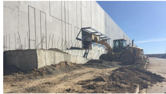
Ausbau in den USA
